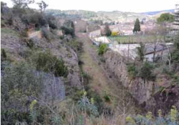
Fig. 8 : Tranchée de la voie ferrée de Saint-Ambroix
