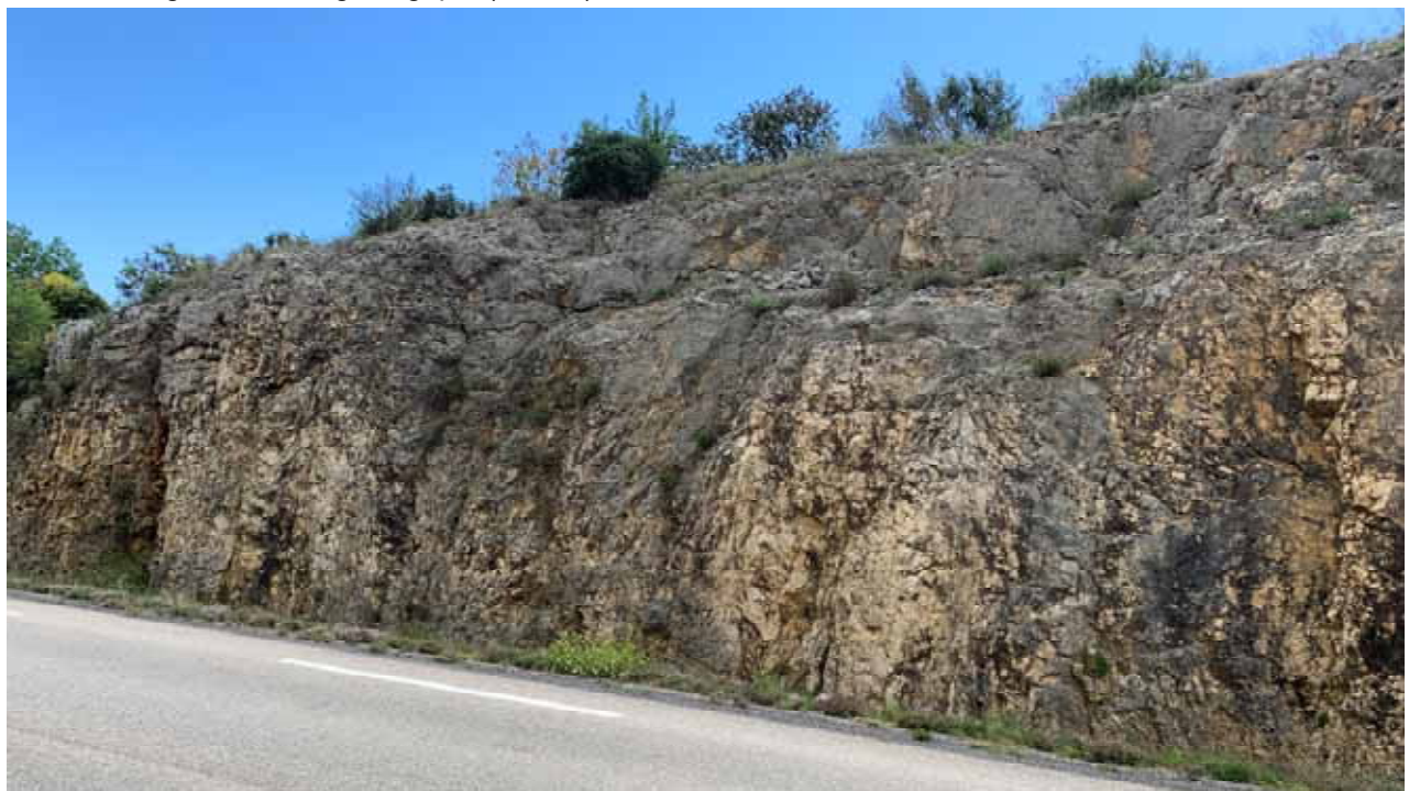
Fig. 28 : Flanc nord (photo JP Rolley)
