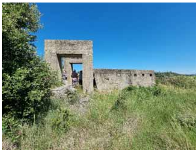
Fig. 43 : Arches en bétons (photo Ph Gaubert)
