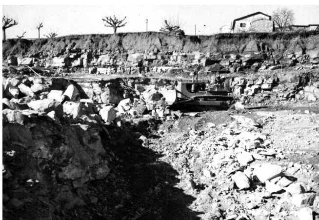
Dégagement du minerai abattu au bulldozer. Remarquer la disparité de taille des blocs dont les plus gros devront être réduits à moins de 800 mm avant transport à la laverie
