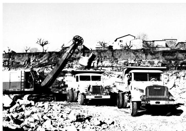
Chargement des camions tombereaux par pelle mécanique
