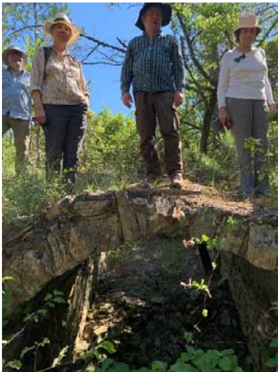
Fig. 4 : deuxième petit pont (ph JP Rolley)
