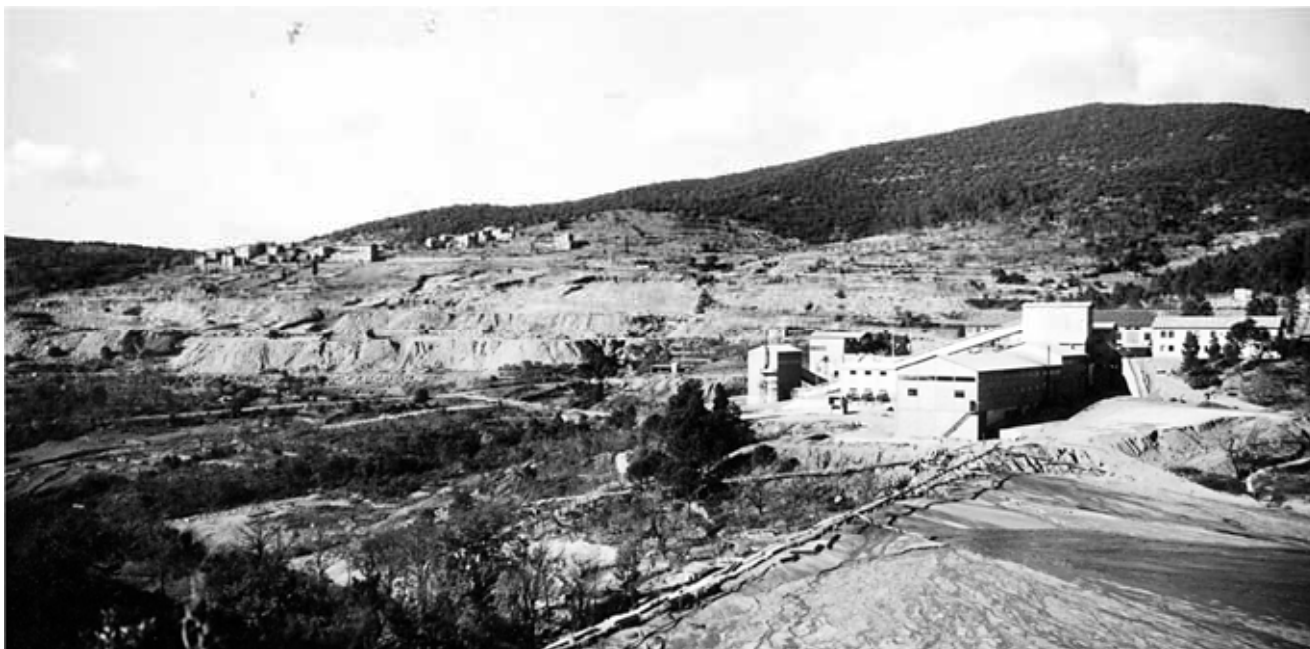
Vue générale du site en exploitation. En arrière-plan le hameau de Carnoulès, au-dessous les carrières d'exploitation en gradins, à droite l'usine de traitement, au premier plan le dépôt de résidus et stériles. (Photos DREAL)
