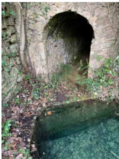
Entrée de la mine et bassin de stockage (ph JP Rolley)
