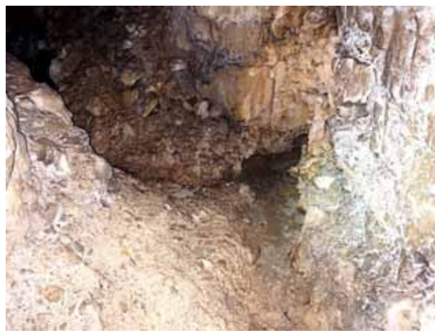
Salle terminale montrant 2 des arrivées d'eau et le départ du canal d'écoulement gravitaire.
