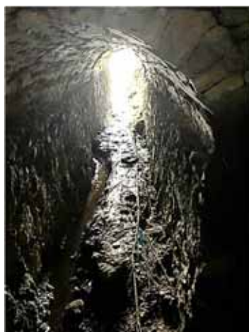
Section maçonnée de la galerie, vue du fond. Le canal d'écoulement de l'eau est visible sur la gauche.
