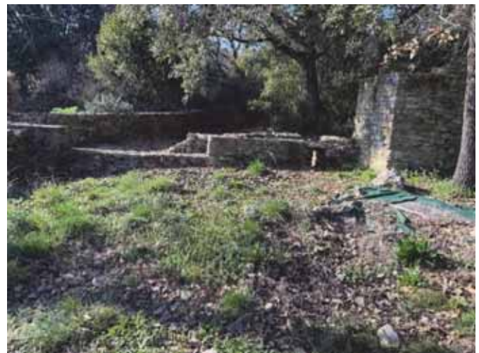
Fig.13 : reste de bâtiments miniers ?
