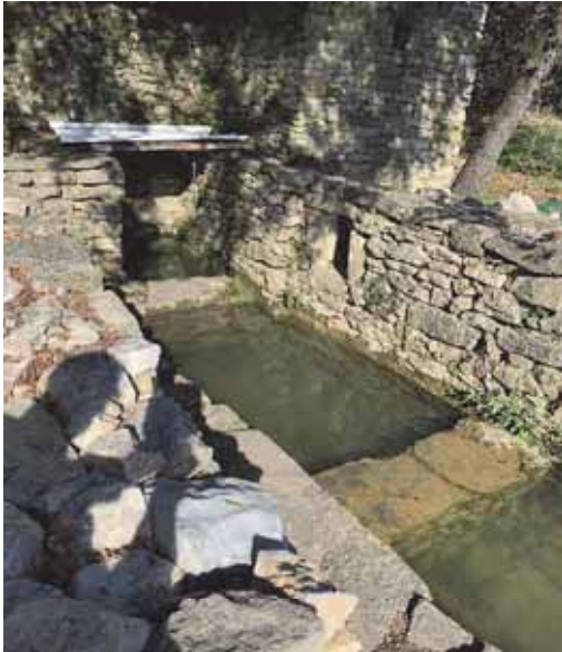
Fig.14 : Source liée à une ancienne galerie ?
