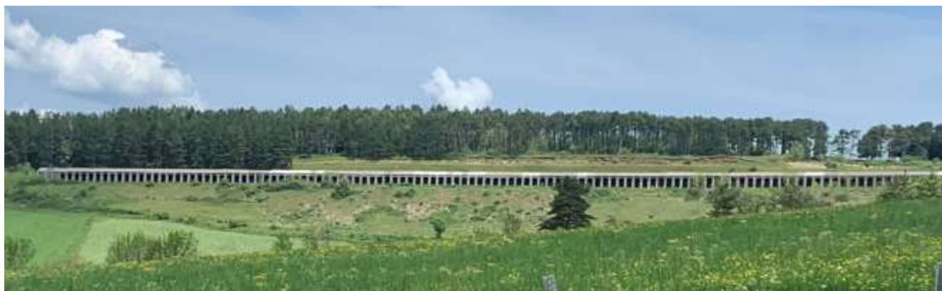
Fig.18 : La voie de chemin de fer couverte de Larzalier
