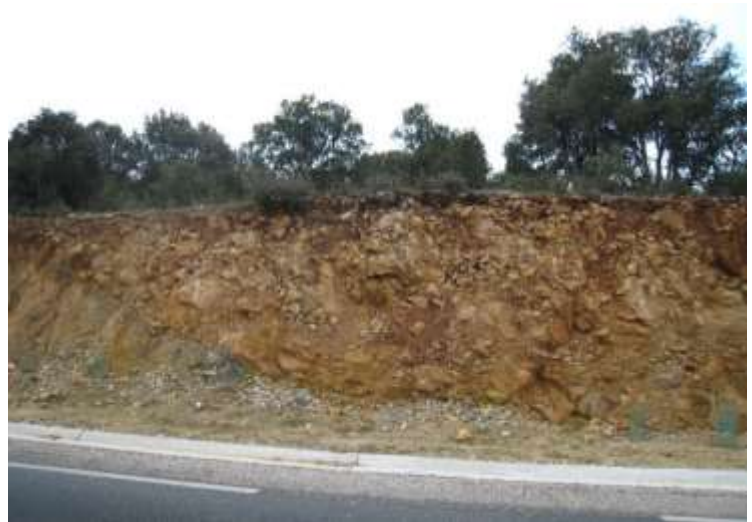
Fig.17 : Crétacé supérieur le long de la départementale (photo JP Rolley, prise en 2010 juste après les travaux d'élargissement de la route)
