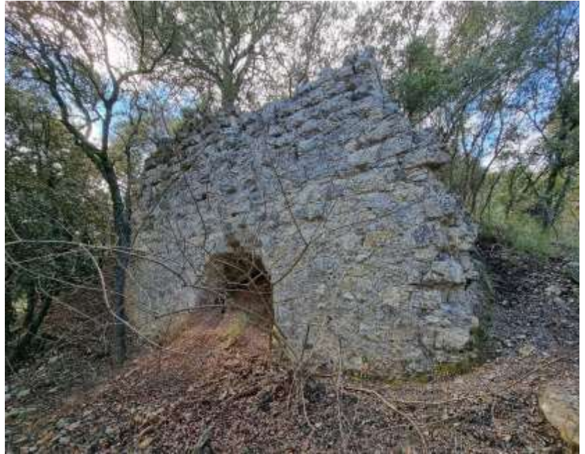
Fig.25 : Ruines du four à chaux (ph. Ph Gaubert)
