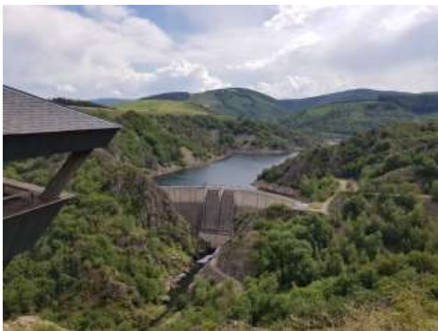
Fig.28 : Le barrage (photo M. de Gouvenain)
