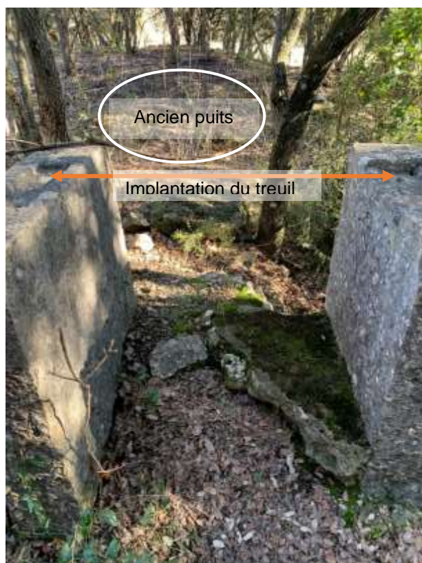
Fig.22 : Reste de l'implantation d'un treuil et au fond trace d'un ancien puit (ph. JP Rolley)
