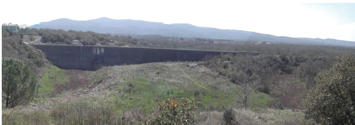
Photo 3 : Barrage "sec" de Conqueyrac
