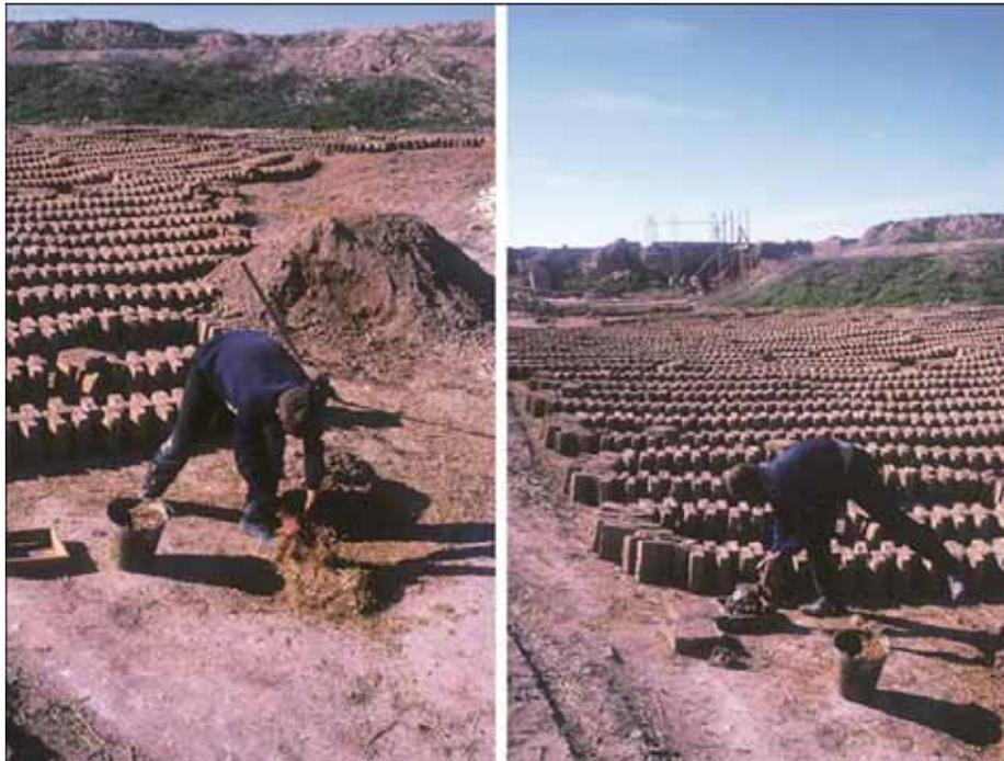
Fig. 7 : Abbas, le maçon, confectionnant des adobes pour la restauration à Suse
