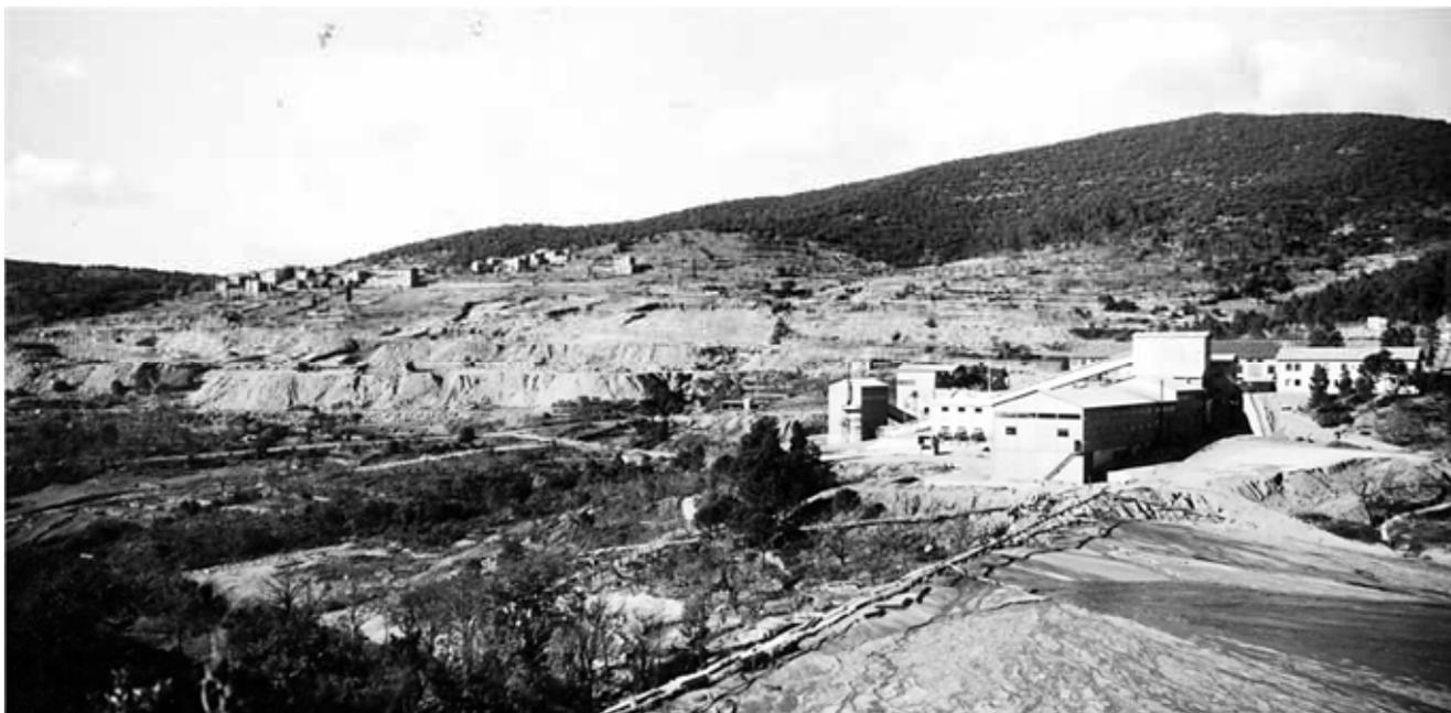
Vue générale du site en exploitation. En arrière-plan le hameau de Carnoulès, au-dessous les carrières d'exploitation en gradins, à droite l'usine de traitement, au premier plan le dépôt de résidus et stériles.
